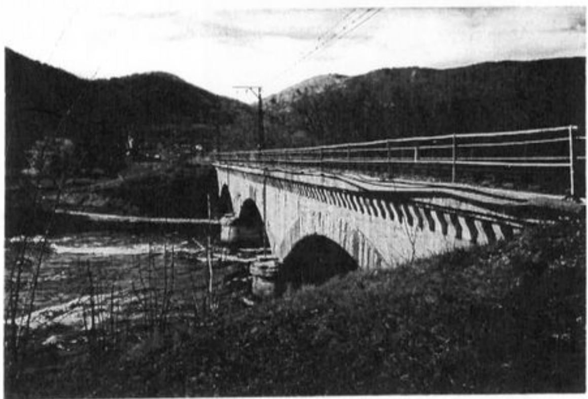
3 - Le pont de chemin de fer enjambant la garonne. ( le village de Saléchan en arrière plan )
